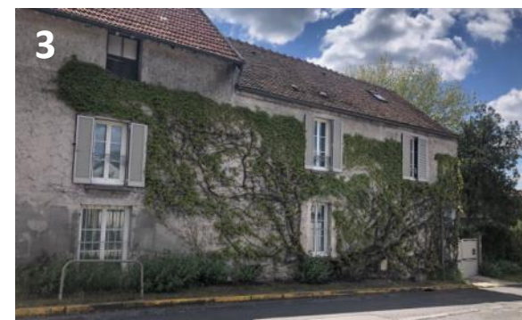
Corps de bâtiments rue du Fort du Bois
