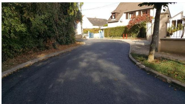
Les travaux ont été réalisés en partenariat avec la CAMG sur un affaissement de la chaussée, gênant le passage de tous les véhicules.
