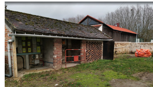
Travaux effectués : Reprise du mur soutenant les différents compteurs des bâtiments du pôle du Laurençon.
