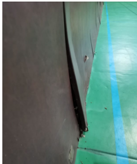
Verre sécurit cassé risque de chute de débris
